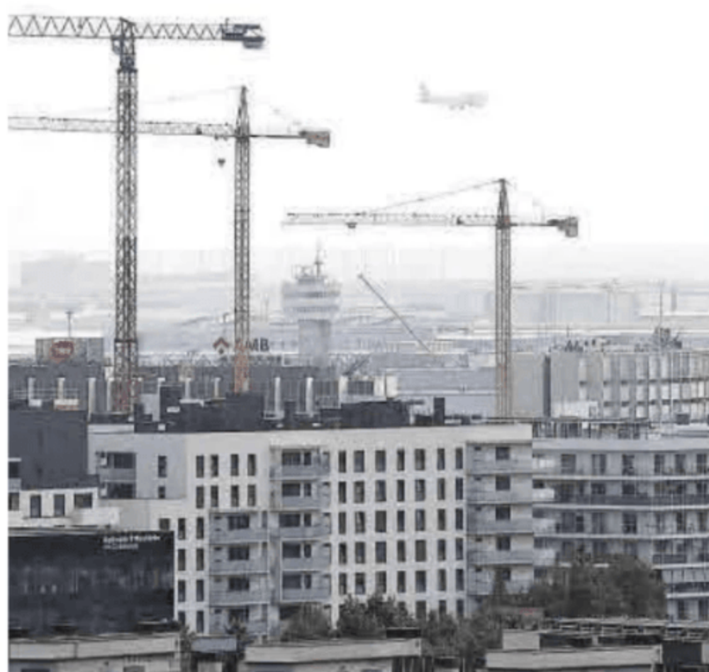
Construcción de una nueva promoción de viviendas.
